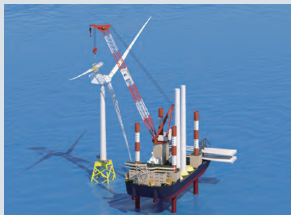
④風車設置イメージ(SEP船)
