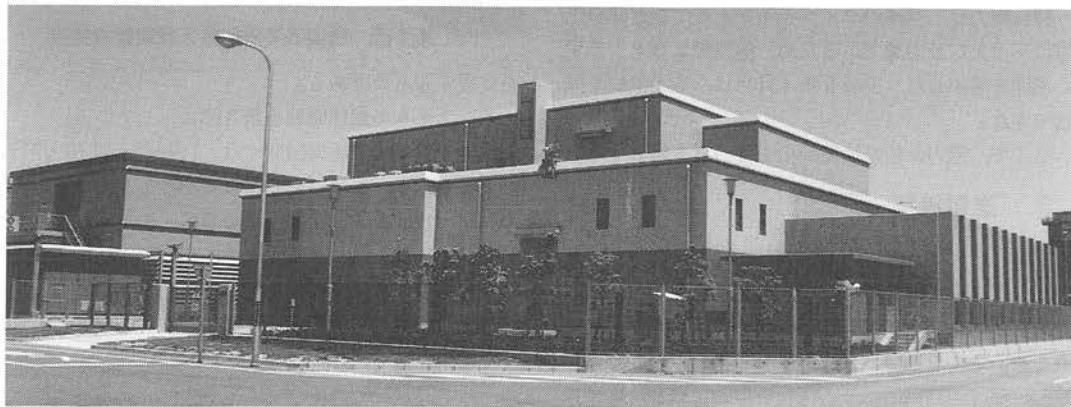
写真-1 関西国際空港変電所
