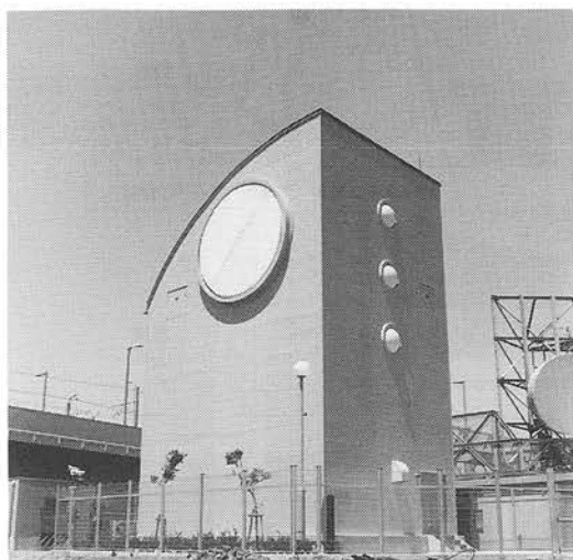
写真-2 無線中継所
